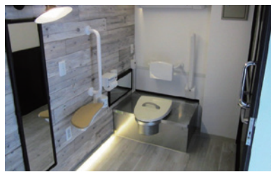
苫小牧市が導入した「福祉トイレカー」内装
