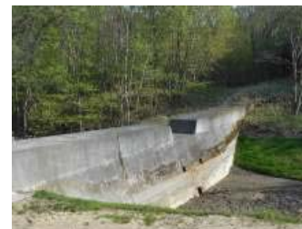
構内に設けられた砂防ダム
