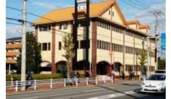
平成18年度「まちなみ景観大賞」を受賞した本社社屋
