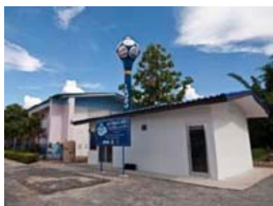
寄贈された浄水システムの建屋
