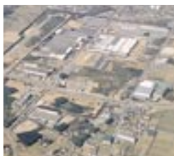
栃木工場 全景
