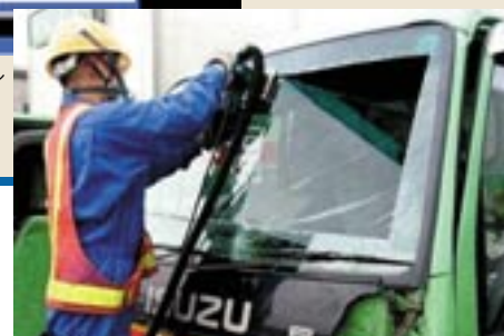
ガラス回収作業風景
