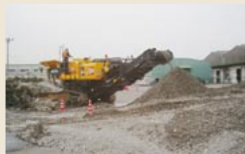
コンクリートガラ再生状況
