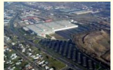
DMAX, Ltd. 工場全景
