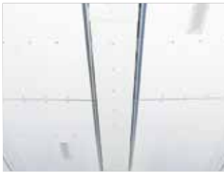
天井(センタービーム保冷シール)
