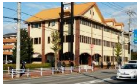
平成18年度「まちなみ景観大賞」を受賞した本社社屋
