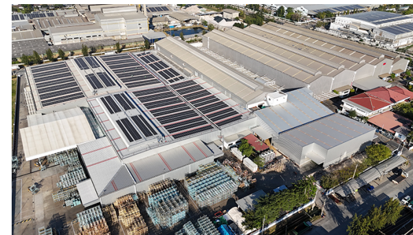
タイ インターナショナル タイ メイキング（TID）の太陽光発電設備
