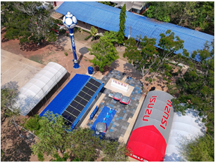
浄水設備用ソーラーパネル
