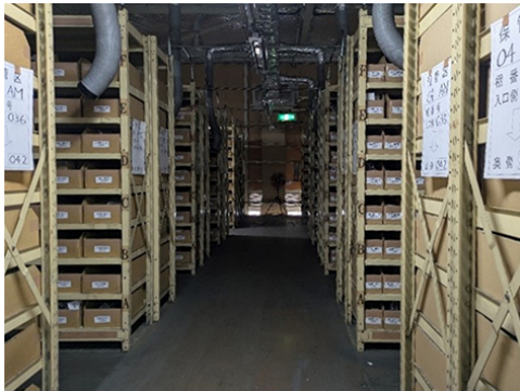
人感センサーにより無人時に消灯された倉庫
