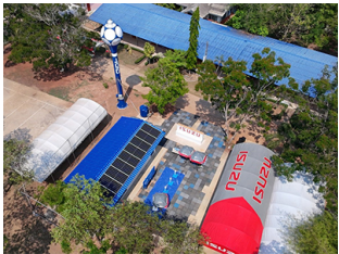
浄水設備用ソーラーパネル
