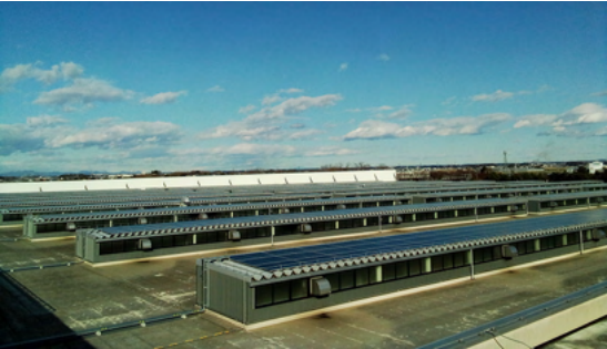
栃木工場の太陽光発電設備
